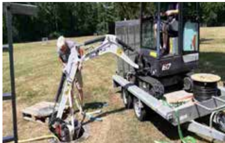
Bild: Tauschen der Pumpe
